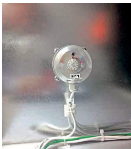
Slika 49: Stikalo diferenčnega tlaka za filtre za sveži ali odvodni zrak.
